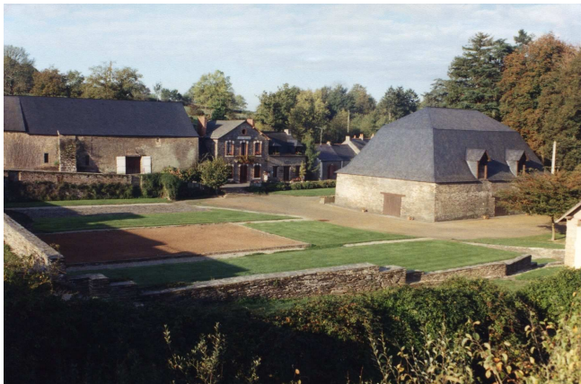
Site de l'ancien camp de Moisdon-la-Rivière. Certains internés logeaient dans les bâtiments en dur, d'autres dans leurs verlines stationnées sur le terre-plein. (Cliché J. Sigot)
